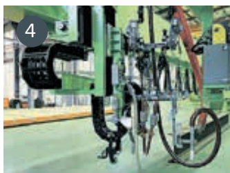
4 Оборудование для сварки встык, сварка с внутренней стороны полотна
